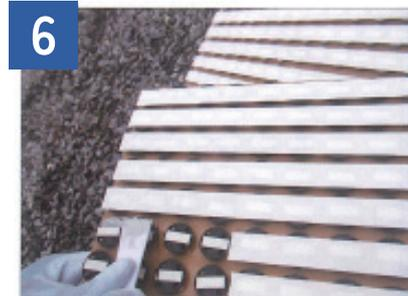
6 専用取付具の両面テープのない箇所に接着剤を塗布します。
