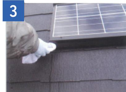
3 専用取付具の取り付け箇所の汚れを雑巾で拭き取ります。
