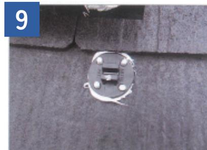
9 設置した際に専用取付具の4つの穴から接着剤がであればOKです。
